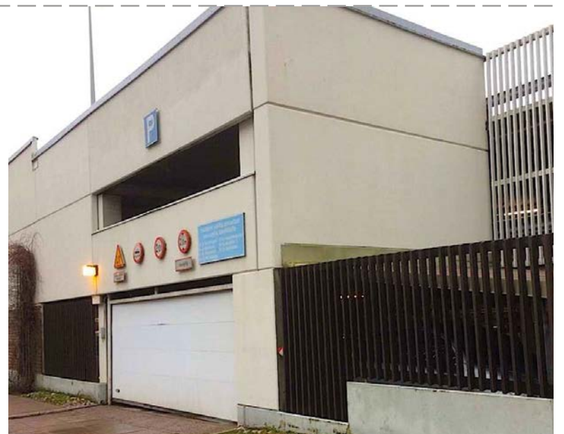
Kiinteistö Oy Kivenlahden Pysäköintitalo sijaitsee Kivenlahdessa, Merivirta-korttelissa.
