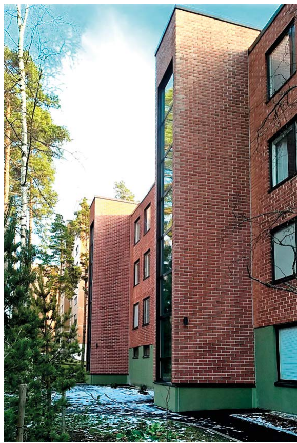
Matinkyläntie 40:n julkisivu ennen (yllä) ja jälkeen (alla) hissien asennuksen. Hissikuilut sulautuvat hyvin tiiliseinustaan.
