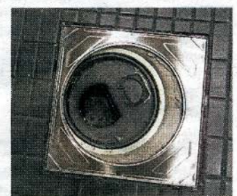
Väärin asennettu lattiakaivo.
